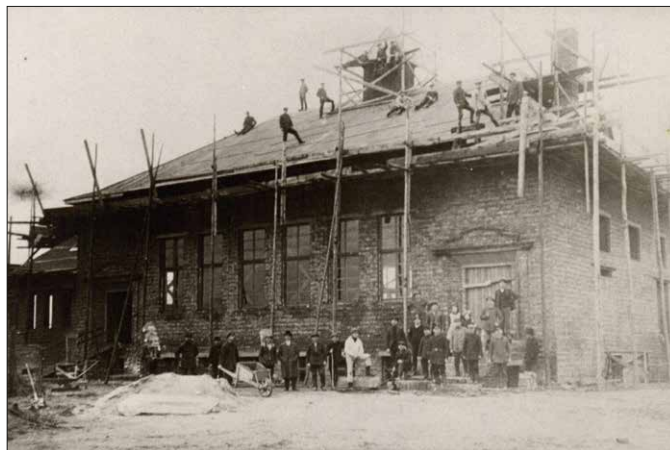
Bau der Sport- und Kulturhalle 1928
