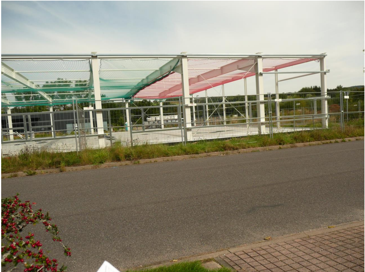
Abbildung 8 Gewerbegebiet Dresdner Straße
